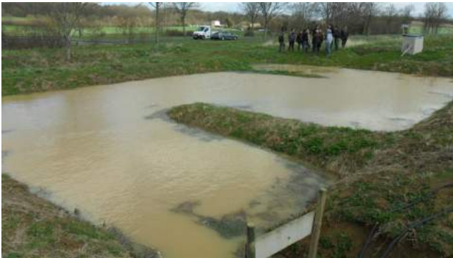
Photo 6 : Mare en S - S destiné à ralentir la circulation de l'eau et augmenter le temps de dégradation des molécules (Source : CRA de Lorraine)
