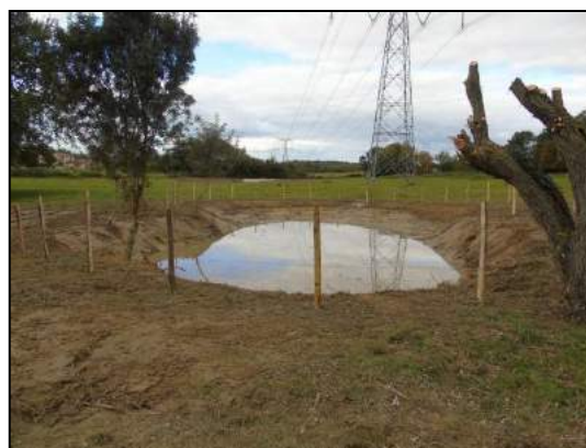
Photos 2 et 3 : Restauration d'une mare drainant des eaux de ruissellements en provenance de cultures et mise en défens pour stopper le piétinement par les vaches – Avant et après travaux. Commune de Valeins.
