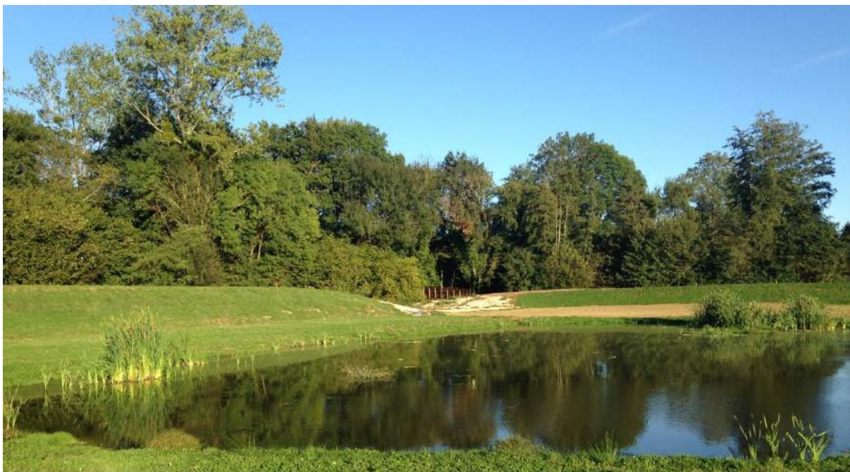
Photo 11 : zone de rétention des eaux pluviales aménagée en bassins imbriqués et comportant une zone humide centrale – commune de Saint Etienne sur Chalaronne (Source : SRTC)
